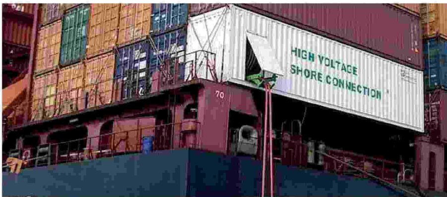
Una nave ferma in banchina con il sistema del cold ironing
